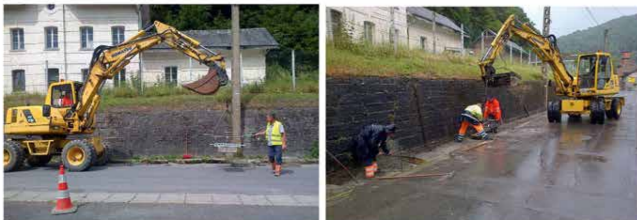
Remise à niveau de filets d'eau à La Roche
